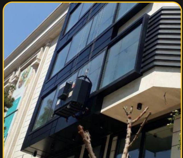
مونوریل ها وسایل بسیار مناسبی برای جایگزینی سیستم هایی که به اصطلاح به آنها اسپایدر میگویند هستند. سیستم هایی که برای بالا رفتن و جابه جاشدن روی نمای ساختمان به منظور شستشو و ... استفاده میشوند
